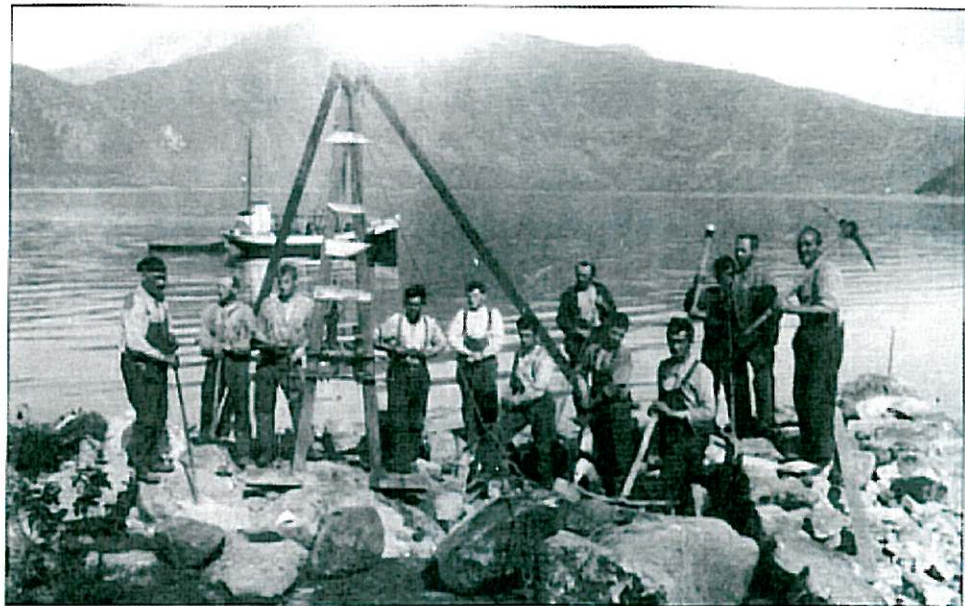
Arbeidet på fabrikkromta er i gang, 1928-29.
